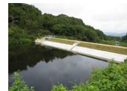
老朽化したため池の 全面改修
