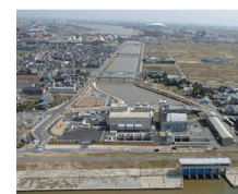
排水機場の整備
