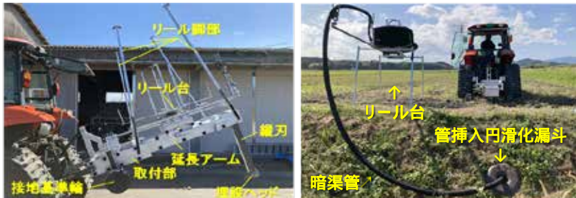
排水管理設装置および暗渠管の施工作業の様子
