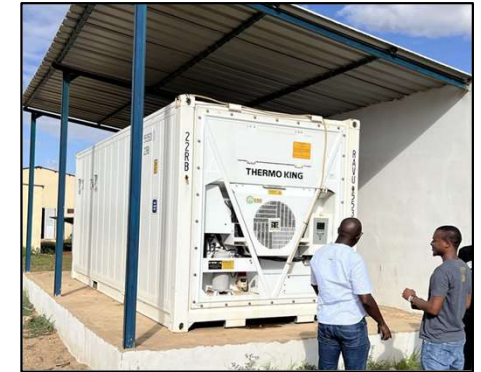
オフグリッド型リーファーコンテナによる冷蔵貯蔵施設
