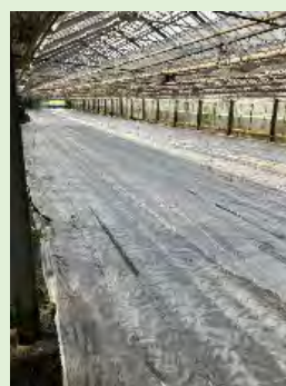
被覆後の様子
