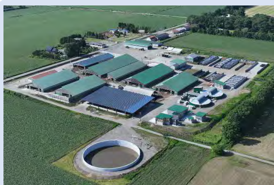
バイオガスプラント（R5年3月完成）
