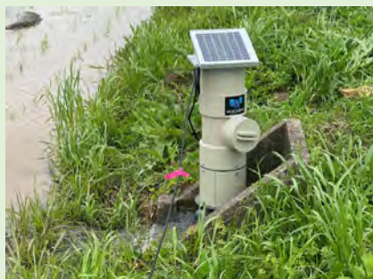
○ほ場水管理システム
