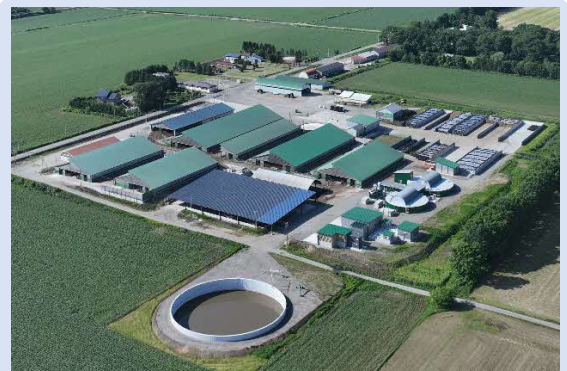
バイオガスプラント（R5年3月完成）
