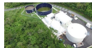
バイオガスプラント(八重瀬町)
