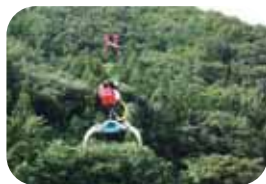
架線式グラブプルは再生電力を使用
