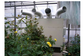
燃油使用量の低減に資する施設園芸用ヒートポンプ
