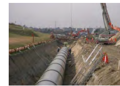
水路のパイプライン化
