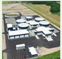
バイオガスプラント (令和7年10月稼働)
