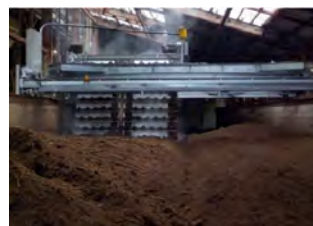
堆肥自動攪拌機
