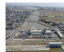
排水機場の整備
