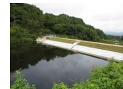
老朽化したため池の 全面改修
