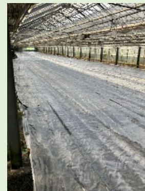
被覆後の様子
