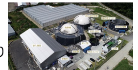
バイオマスプラント
