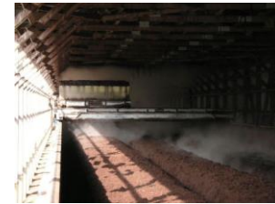
堆肥センター
