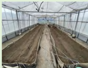
電熱線の設置
