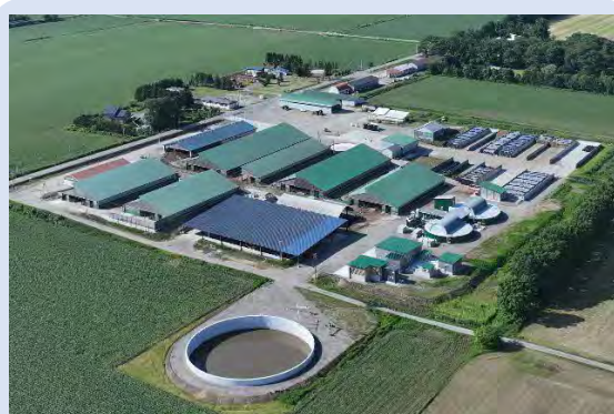
バイオガスプラント（R5年3月完成）
