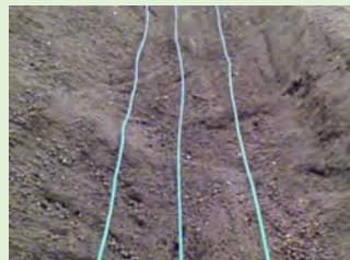
電熱線設置の様子
