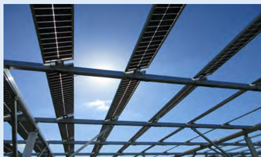
●先進事例調査（千葉県匝瑳市）
