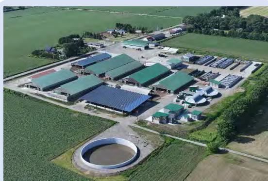
バイオガスプラント（R5年3月完成）
