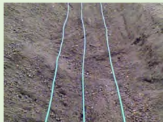
電熱線設置の様子
