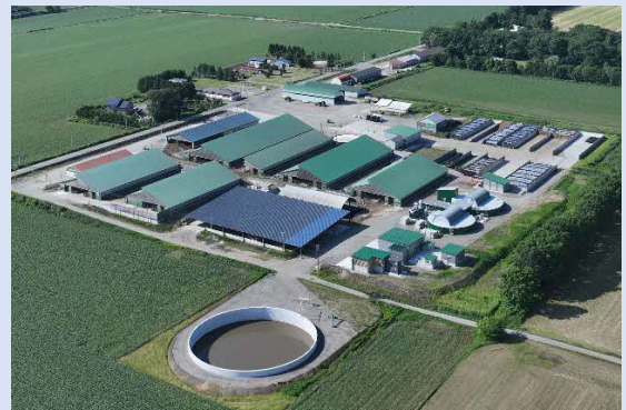
バイオガスプラント（R5年3月完成）
