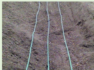
電熱線設置の様子
