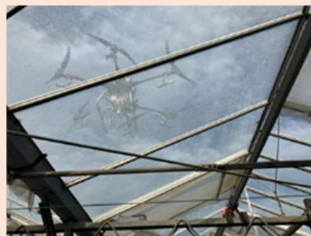
ドローンによる遮光資材塗布の様子
