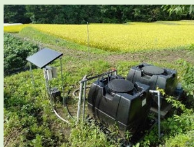
ソーラーパルサーE（蓄電式ソーラー自動かん水システム）の設置状況
