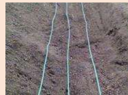
電熱線設置の様子
