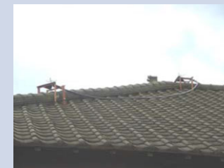
畜舎屋根へのスプリンクラー設置
