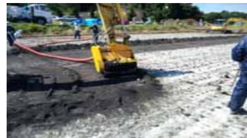
固化剤を用いた削り取り
