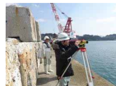
防波堤復旧工事の出来形確認
