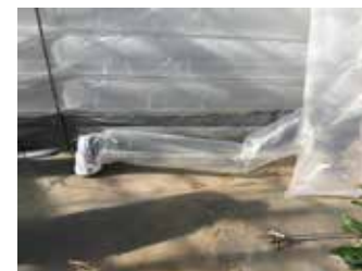
送風機取付時
