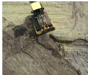
農業ブルドーザによる畔倒し
