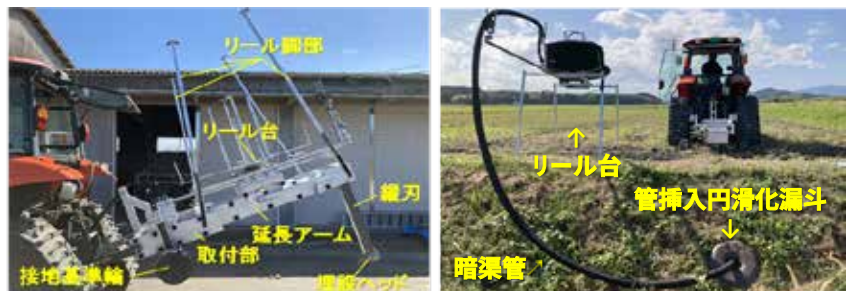
排水管理設置装置および暗渠管の施工作業の様子
