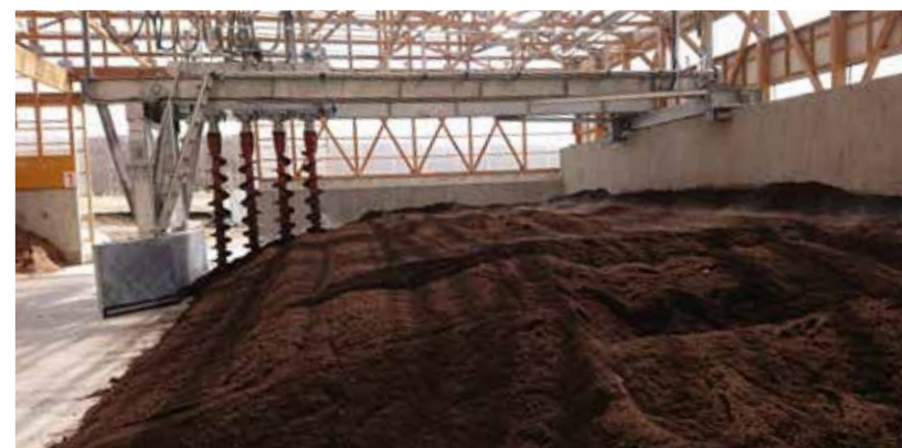
堆肥原料の自動攪拌機
