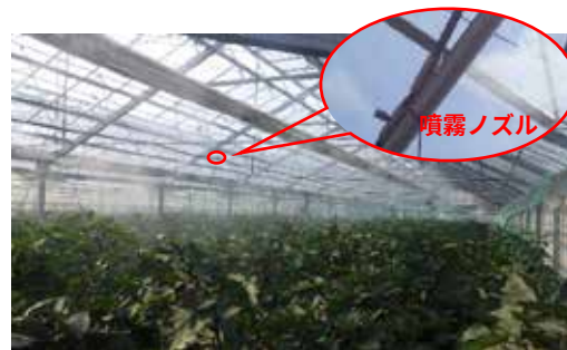
左：細霧冷房設置温室とノズル、右：CO 2 施用チューブとポンペ
