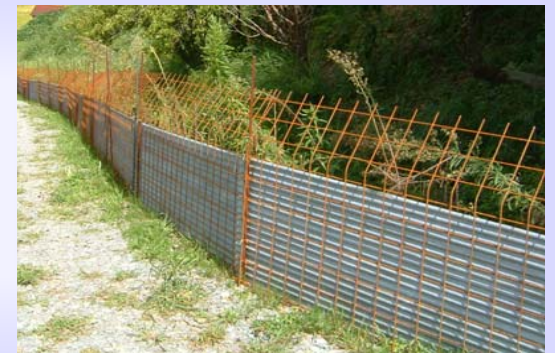
↑「忍び返し」の施工例（滋賀県日野町）
