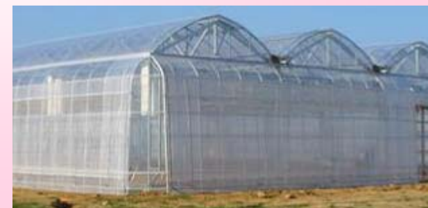
↑ 超低コスト耐候性ハウスの外観
