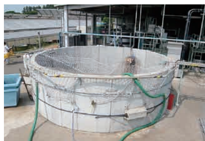
消化液貯留槽
