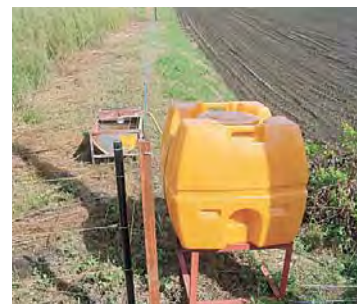
<ポリタンクを利用した貯水タンク>
