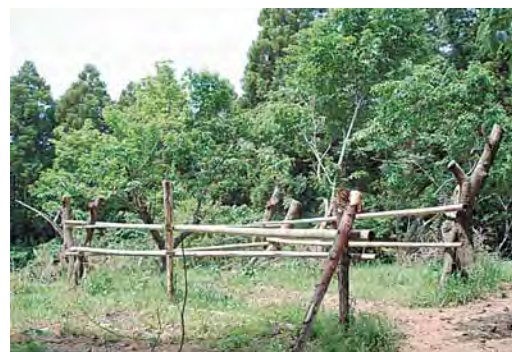
<杭を打ち孟宗竹を針金で縛り付け>
