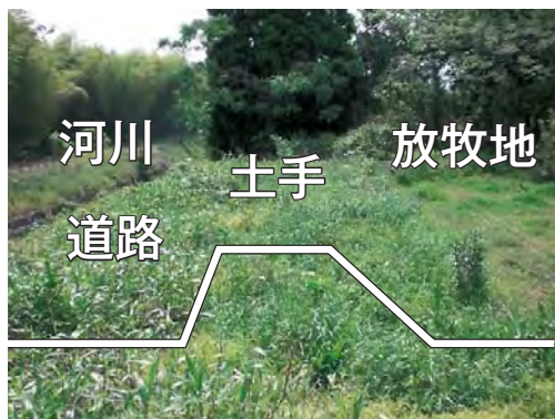
＜ 左手：河川・道路、右手：放牧地。 中央に幅約1.3m、高さ約40cmの土手。＞
