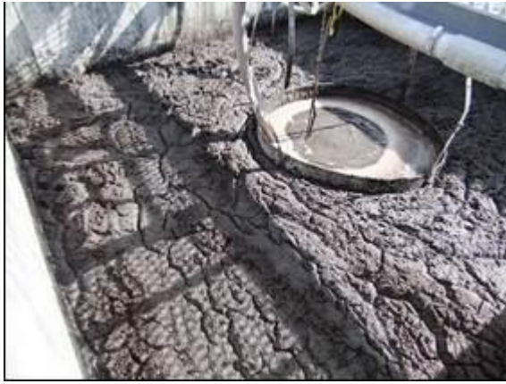
膜分離導入前の沈殿槽の状況
