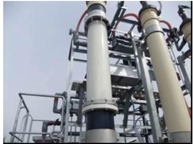
従来の浸漬型の一例（曝気槽に水没させ使用） 開発した外付け型（曝気槽の外側に取付けて使用）
