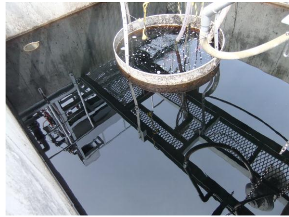
導入後の沈殿槽の状況(放流槽として使用)
