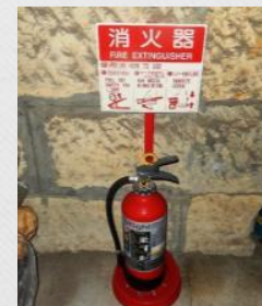
消火器を設置
