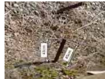
突き出たアングル（杭）
