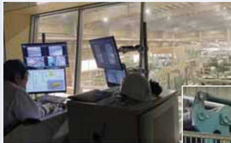
製材機械の監視室
