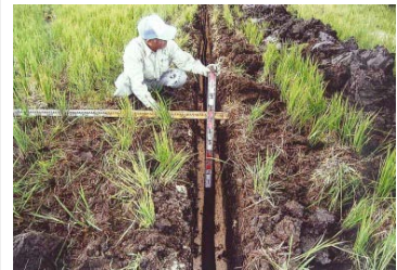
施工状況（暗渠排水）
