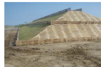
建設発生土により造成した人工砂丘
