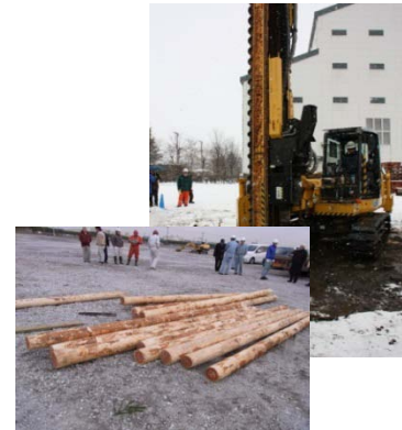
液状化対策実験への 国有林材利用
