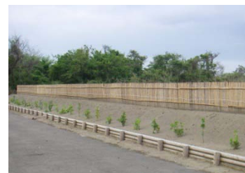
建設発生土による植栽基盤の盛土、植栽
