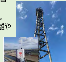
携帯電話基地局の中に設置した無線基地局（LPWA）
