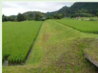
（緩傾斜化された斜面）
