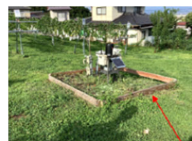
侵入防止柵の設置
