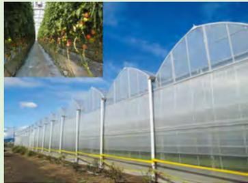
遮光カーテンや細霧冷房装置等の環境制御装置を装備している高軒高ハウスを導入することで、管理作業の効率化により管理コストを削減
