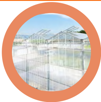
高度施設環境制御 生産量↑/品質↑/リスク↓
