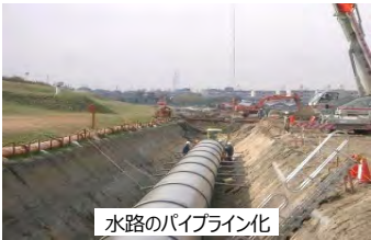
水路のパイプライン化
