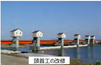
頭首工の改修
