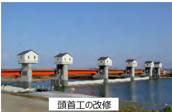
頭首工の改修
