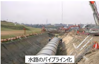
水路のパイプライン化
