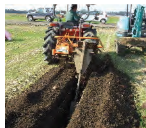
暗渠排水の整備
