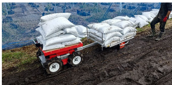
本体 + 牽引台車で土袋を搬送
