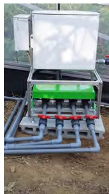
遠隔自動灌水システム「web-ドリップパー」
