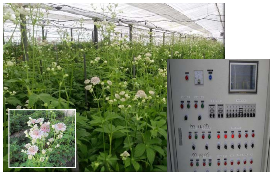
複合環境制御装置を設置した草花栽培ハウス
