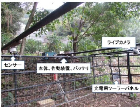
写真1 遠隔監視型捕獲システムの設置状況
