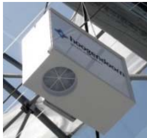
高度環境制御 システムのセンサー
