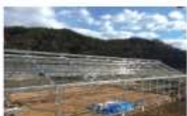
ハウス建設・内部設備
