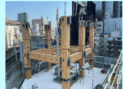
都内建設中の木造ビル（茨城県産木材使用）
